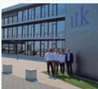
ITK Engineering GmbH. Innovatív irodaépület Németországban. ECOi - PACi
