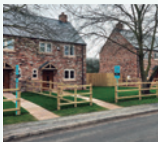
Az újonnan felépített vidéki lakóházakban Aquarea hőszivattyúk biztosítják a fűtést és a meleg vizet (Egyesült Királyság). Aquarea
